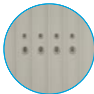
Duża komora spalania wyłożona Acumotte (system otworów w ścianie tylnej odpowiada za napowietrzenie komory spalania) Large combustion chamber - lined with Acumotte (system of holes in the back wall is in charge of the aeration of the combustion chamber) Die Brennkammer ist mit Acumotte ausgelegt – dieses Material verbessert die Arbeitsparameter des Heizeinsatzes Большая камера сгорания выложенная акумотте
